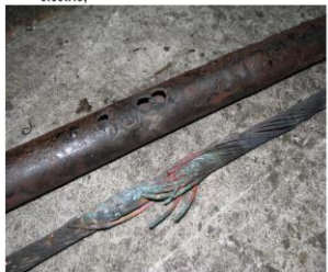
Imaginea 5 – țeava de protecție din oțel găurită și cablul electric topit;
