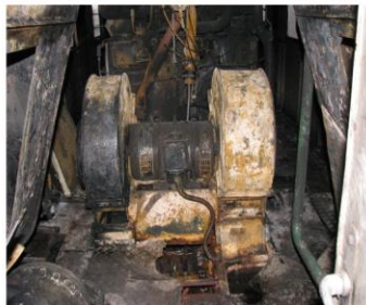
Imaginea 3 – avarii la interiorul locomotivei
